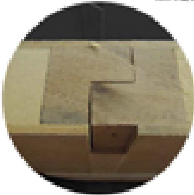
UNIÓN LINEAL EN 'L' ESCALA 1:2
