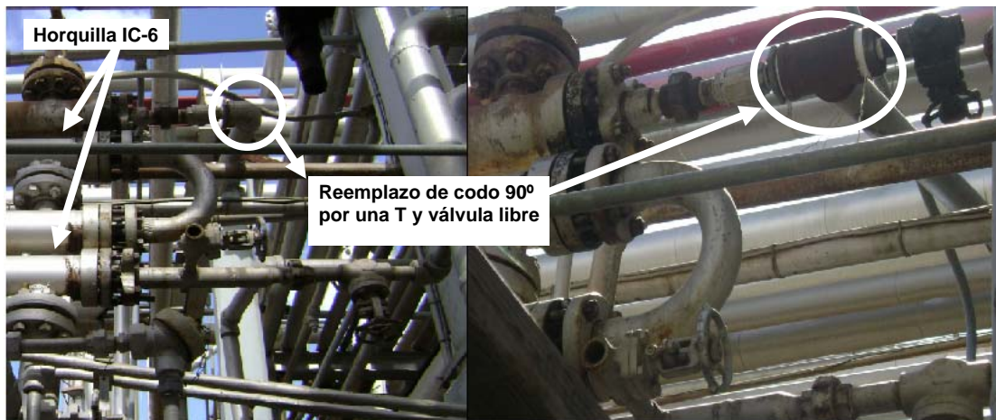
Figura N° 3.6. Modificación de accesorios a la línea de agua a la salida del intercambiador IC-6 (Elaboración propia).
