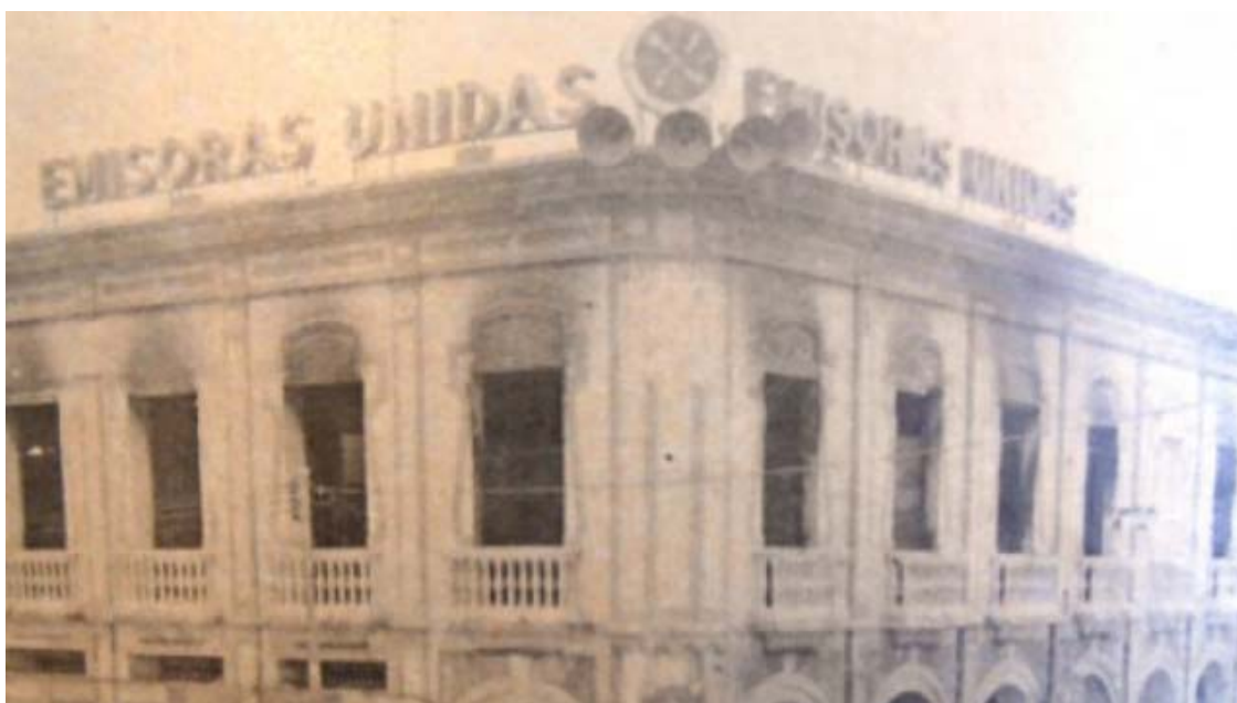
Fig. 13.- Edificio ubicado en la carrera Líbano entre las calles 53 y 54 de Barranquilla, donde el 08-12-1929 inició sus transmisiones de prueba la emisora “La Voz de Barranquilla”
