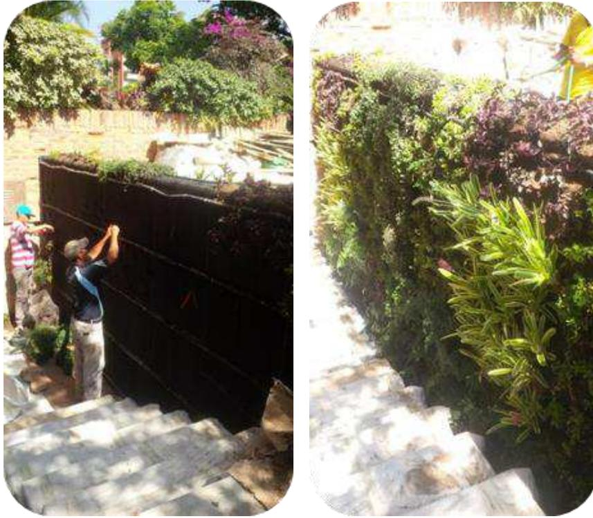
Ilustración 13: Ejemplo de muro vivo. Manto y malla fijado directo a pared. Fotografías: de la autora.
