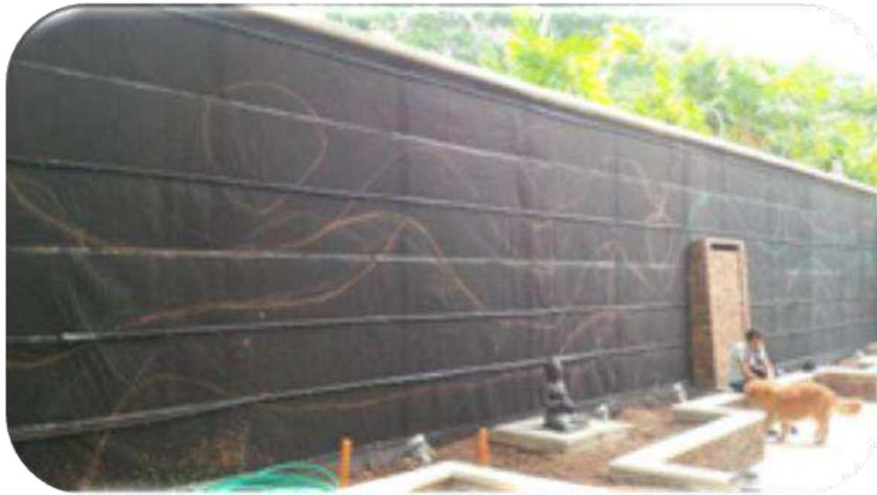
Ilustración 34: Replanteo del diseño para el jardín vertical. (Tomada por el autor)
