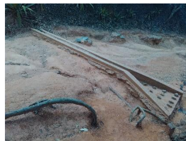
Figura 26: Canales de drenaje del sendero “Sabas Nieves I” - “Sabas Nieves II”
