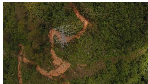
Figura 55: Vista aérea de torres de alta tensión en Zona de Amortiguación
