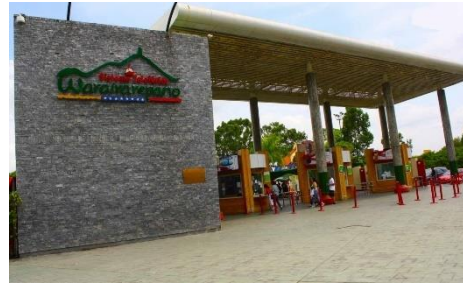
Figura 90: Facilidades para el control de acceso del Sistema Teleférico Warairarepano
