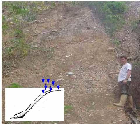
Fig.24 Erosión Laminar Cuenca de Tanaguarena.
