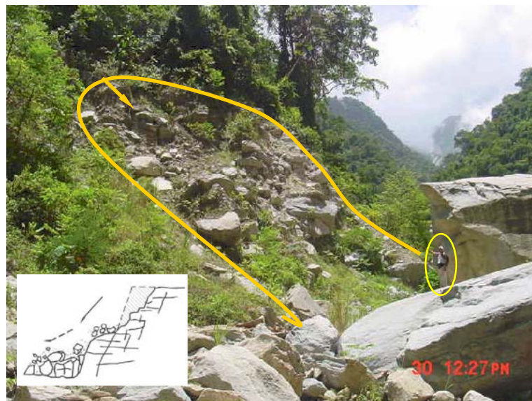
Fig.21 Derrumbe en la Cuenca del río Naiguatá.
