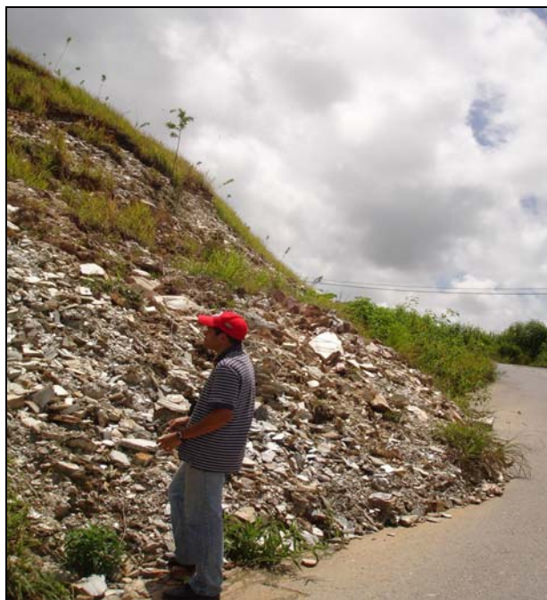
Figura 17: Proceso en el talud. Vía el Encantado. Foto con Azimut de 70°.
