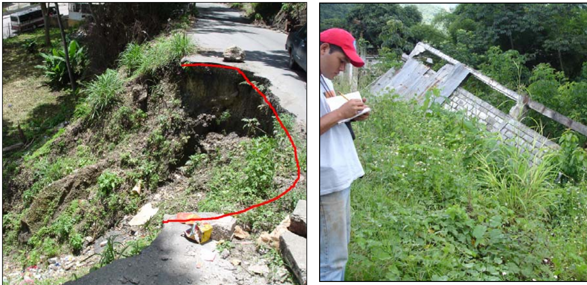
Figura 55: Grietas de deslizamiento en la Unidad de Esquistos Cuarzo Moscovíticos-UEQM – Azimut 60°
