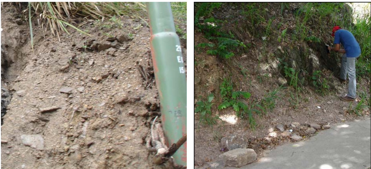
Figura 14: Coluviones constituido por una mezcla heterogénea de materiales sueltos: bloques, fragmentos de roca, angulares a subangulares, en matriz de suelo arenoso-limo-arcilloso. Fotos con Azimut de 210° y 220° respectivamente.
