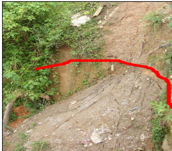
Figura 50: Deslizamiento Rotacional en suelos de la UEQM. Azimut 170°
