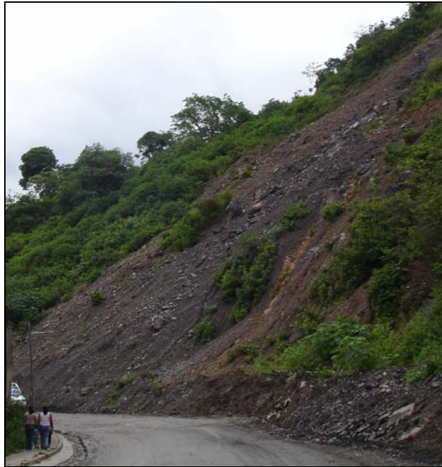
Figura 53: Deslizamiento translacional en Barrio La Cuesta-Vía Carretera Vieja Petare Guarenas- 170°
