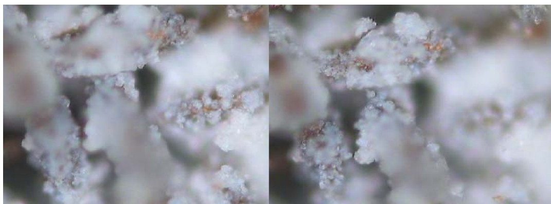
30.b. Detalle sobre los hilos de las mallas de acero.
