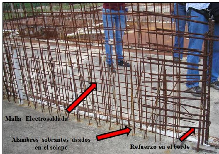
**Figura II.5.** Detalle del acero de refuerzo de un muro. Fuente: FUNVISIS.
