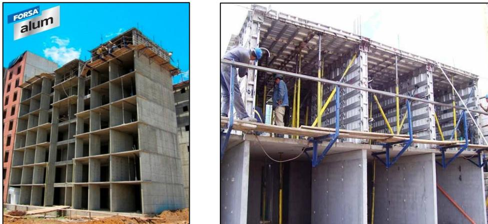
**Figura II.7.** Construcción de edificio de muros con encofrados manoportable.
