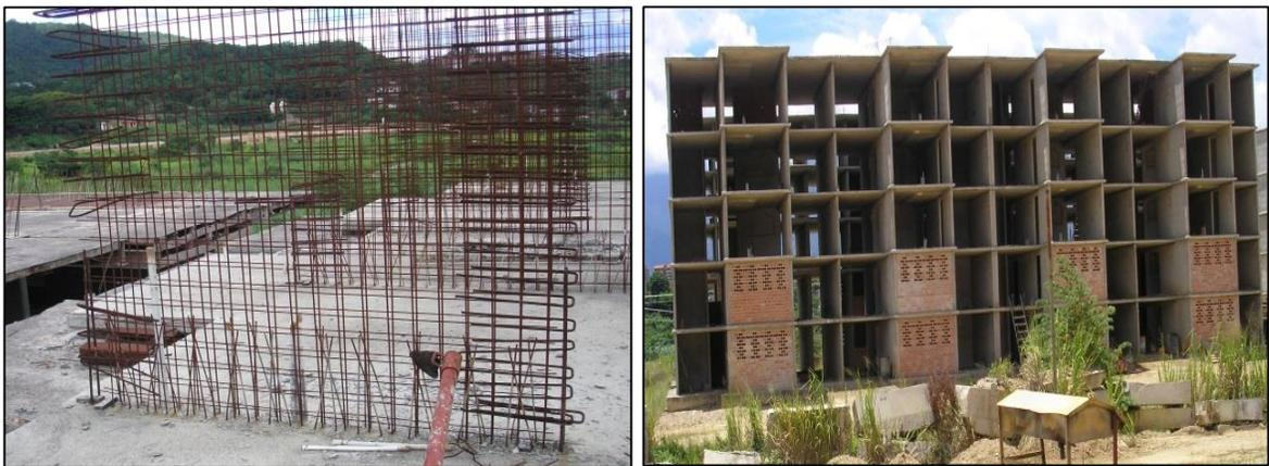
**Figura II.4.** Colocación del acero de refuerzo de un muro a ser vaciado (Izq.). Edificios Tipo Túnel en construcción (Der.). Fuente: FUNVISIS.
