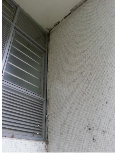
Figura 23. Separación Parasol-Columna y Parasol-Techo. Fuente: Fotografía capturada el día 16-06-2015.
