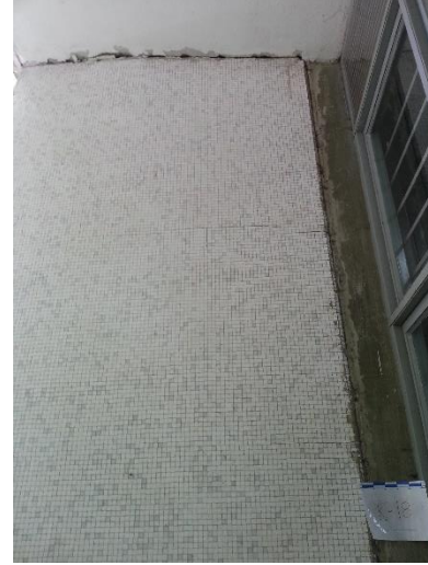
Anexo A. 6. Perdida de recubrimiento en columna K18. Módulo de Dirección.
