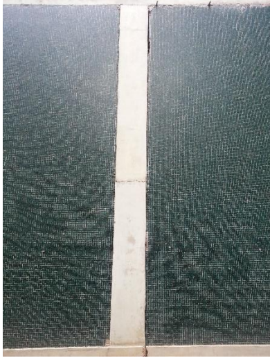
Anexo A. 5. Grieta transversal en columna O18. Módulo de Dirección.
